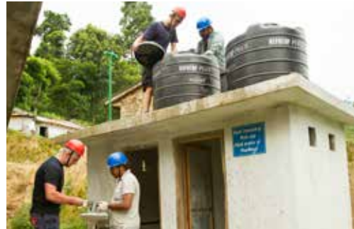
Husene har som regel placeret nogle tanke på taget, hvor vandet opsamles og fordeles rundt i bygningen.
