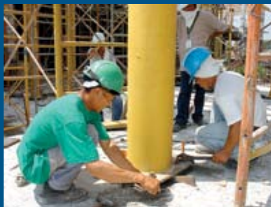
Der er mange løsarbejdere på byggepladserne i Filippinerne. ▶
